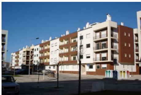
Montiterras – Soc. de Terraplanagens, S.A Urbanização Barreiras Norte – Montijo
